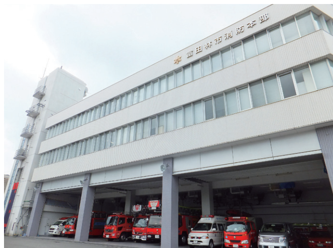
富田林市消防本部庁舎
