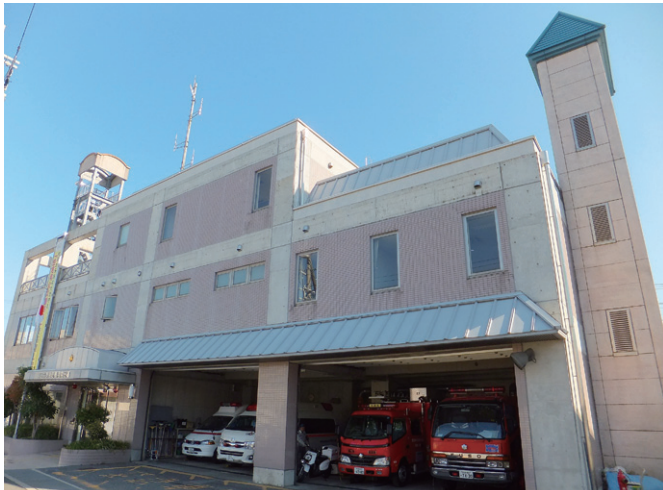
河南町消防庁舎は消防事務委託により河南分署として新たに業務を開始
